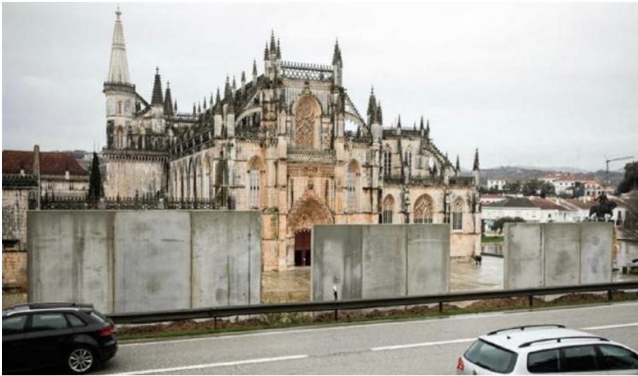
Le mur anti-bruit décidé par la municipalité de Batalha, en construction. Source : site du journal O Observador , janvier 2018
