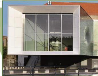
**Etape 4 : Le porte-à-faux à L'avers de la CIDM** : la technique au service du geste artistique. Une partie de la structure de la CIDM n'est soutenue par aucun pilier. Un énorme contrepoids de plusieurs tonnes a été mis en place pour réussir cette performance.
